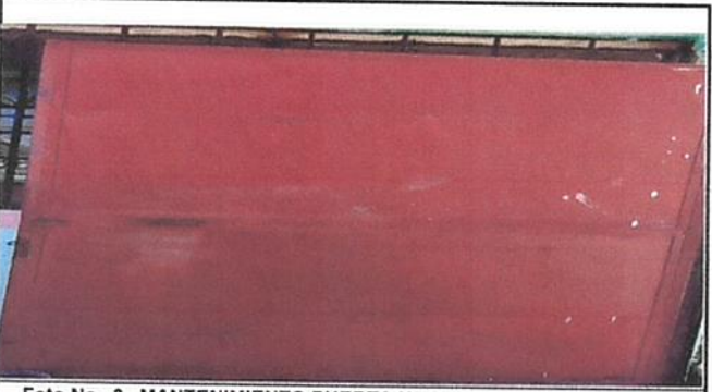
Foto No 3 MANTENIMIENTO PUERTA No 3
