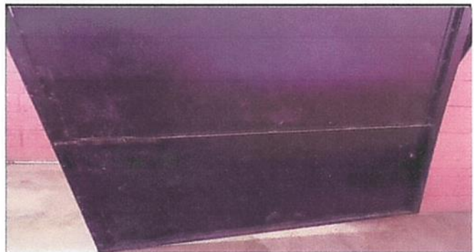
Foto 4 MANTENIMIENTO PUERTAS DE BAÑOS
