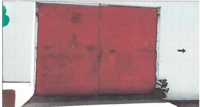
Foto 2: SUSTITUCION PORTON ENTRADA PRINCIPAL
