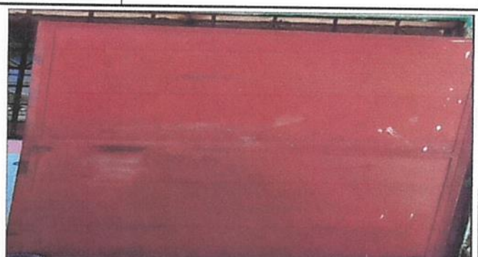
MANTENIMIENTO PUERTA DE AULA No 2
