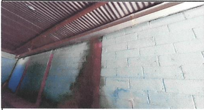
Foto1: SUSTITUCION CANAL CAIDA DE AGUA
