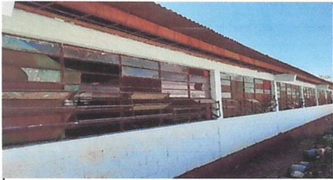
Foto 3 SUSTITUCION DE BALCONES Y VENTANALES
